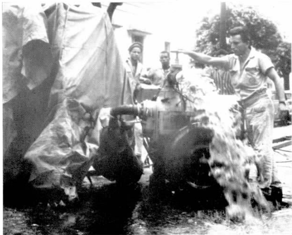
A violência das águas desorganizou todos os serviços públicos, pois a água subiu a níveis jamais alcançados. As galerias de cabos telefônicos subterrâneos foram seriamente invadidas pelas águas. Para esgotá-las foram necessárias poderosas bombas hidráulicas, como nos mostra o clichê.
