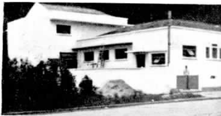
A ala direita da Estação Telefônica de Teresópolis, mostrando a entrada.
