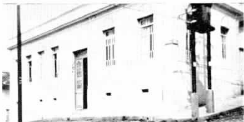
Prédio da Estação da C. T. B. em Pedralva
